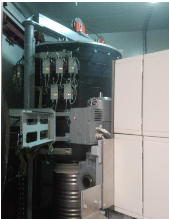
Рис. 5. Система радіаційного контролю бочок перед кондиціонуванням.
